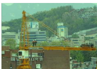
《카운터 지브 설치 완료》
