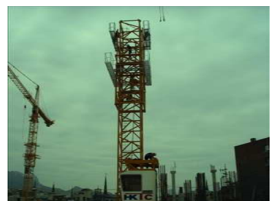
《턴테이블+운전실 설치 준비》
